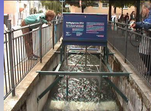
Film: Hubflügelgenerator in Augsburg Mittlerer Lech (Seit Juni 2004)
